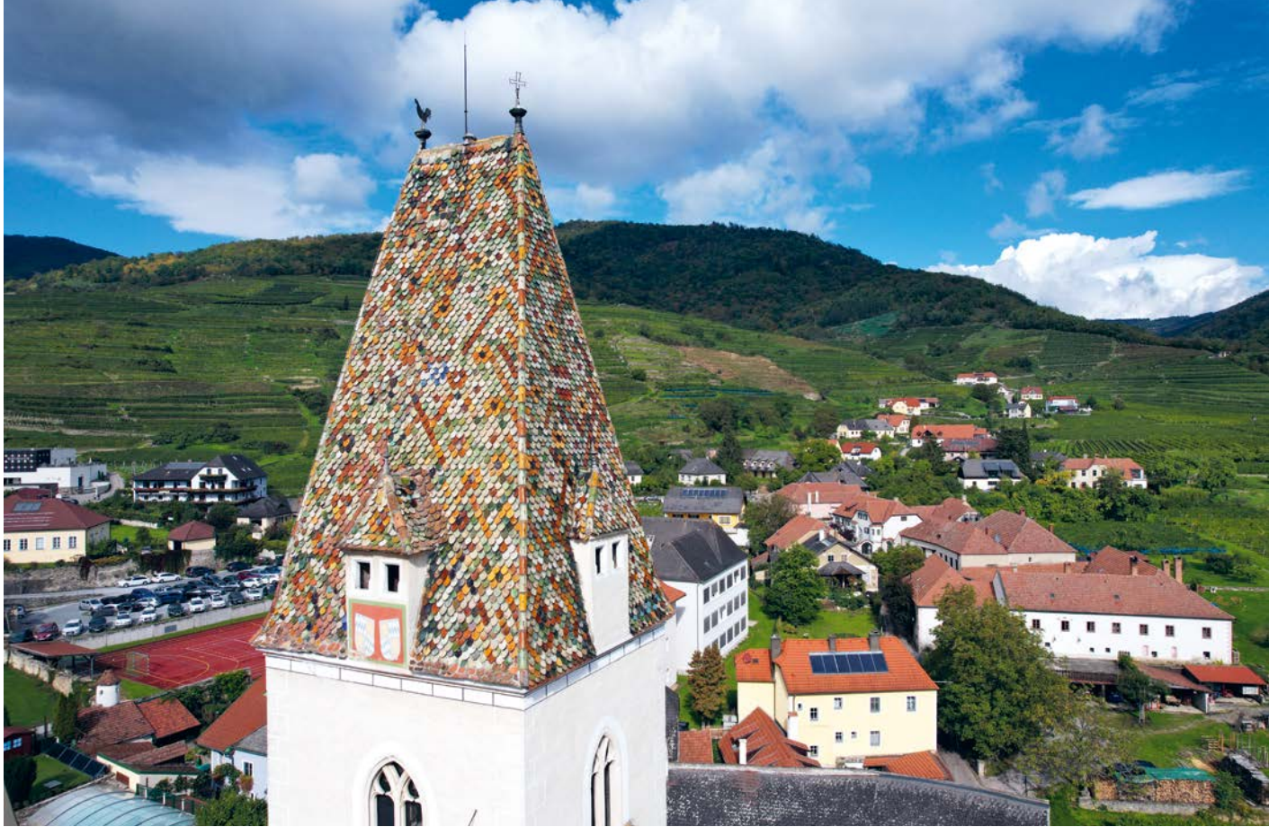
Pfarrkirche Spitz, Turmdach mit spätmittelalterlicher Tondeckung aus polychrom glasierten Dachziegeln
