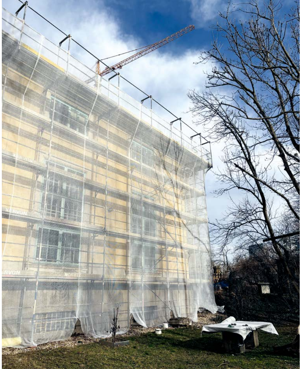
Sanierung der Praterateliers, Ansicht Nordpavillon
